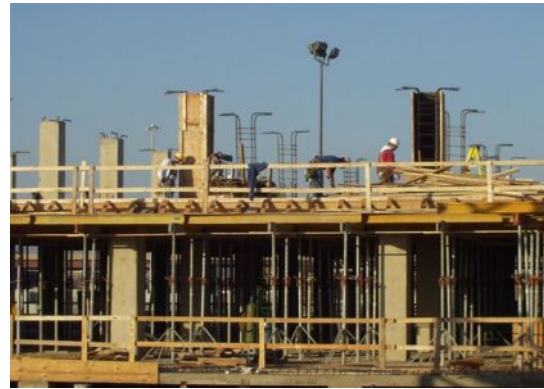
شکل ۵- اجراء قلاب میلگردهای طولی ستون در سقف آخر.
