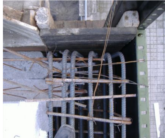
شکل ۱۱- اجرای درست تیرچه به تیر کنسول.
