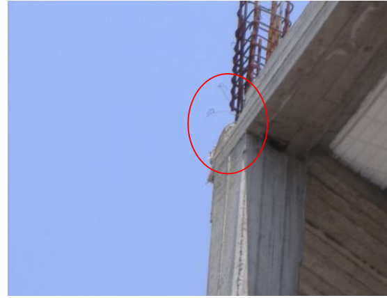
شکل ۲- عدم قرارگیری صحیح آرماتور انتظار در محل تغییر مقطع که ضمن کوتاه شدن بازوی مقاوم سبب شده آرماتور طولی از آن فاصله بگیرد.
