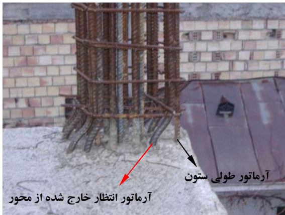
شکل ۳- خم کاری آرماتور های انتظار به علت خارج شدن از محور (آرماتور های انتظار حدود ۸ cm شیفت شدند به سمت راست).
